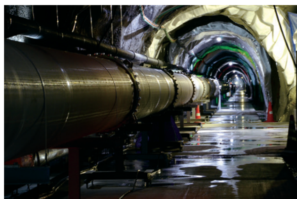
写真：重力波望遠鏡 KAGRA のレーザーを通すダクト (画像提供：東京大学宇宙線研究所 重力波観測研究施設)
