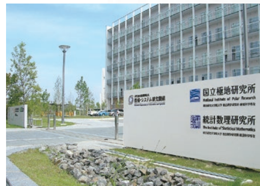
立川市緑町に移転 (平成 21 年 10 月)
