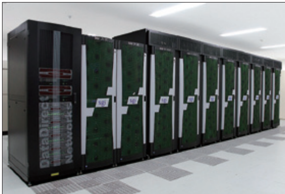
データ同化スーパーコンピュータシステム(A)
