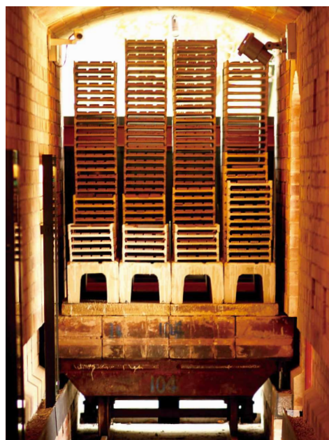
図1. トンネル窯。この写真は伊奈製陶（現LIXIL）のタイル製造用トンネル窯である。ここで行われたタイル実験およびそこで行われた質向上のための効率的な手法は、まさにタグチメソッドのルーツといえる。
