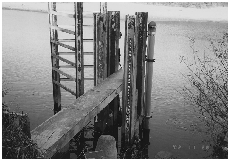
写真 2. 量水標とリードスイッチ式水位計(右の円柱).
